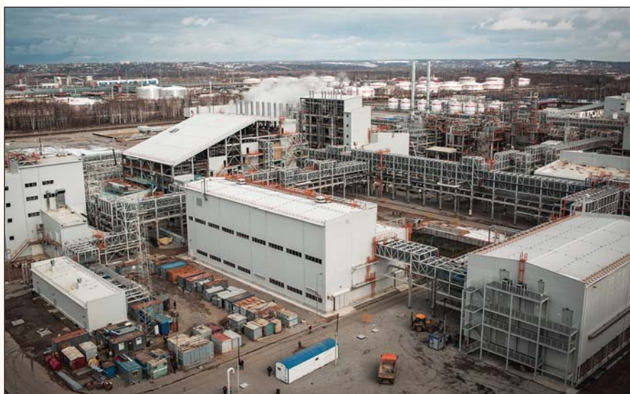
Строительная площадка «Русвинила», март 2014 года
